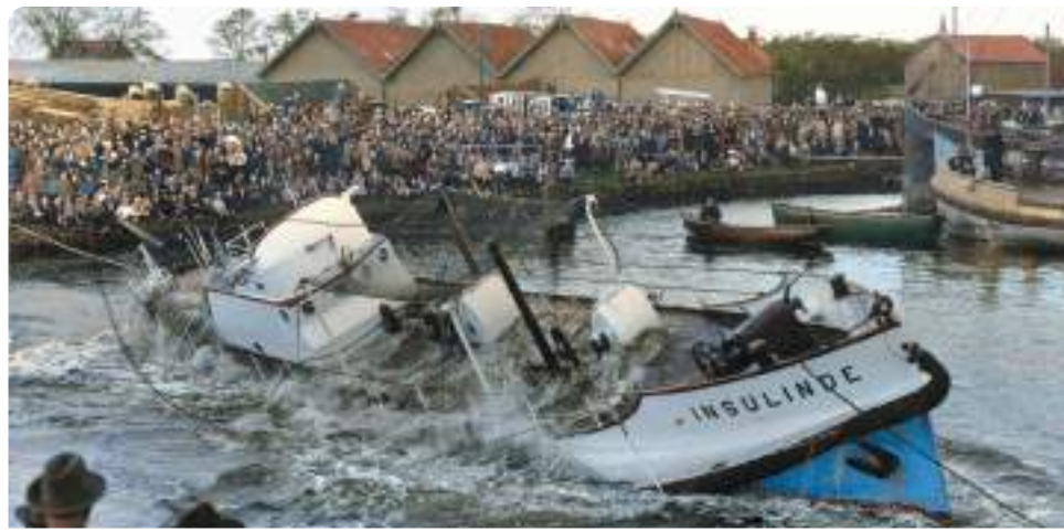
In 1927 wordt, speciaal voor de KNRM de zelfrichtende stalen motorreddingboot ontworpen: de Insulinde. Deze boot draait vanzelf weer rechtop, als hij omslaat. De kantelproef die destijds in Delfzijl werd gedemonstreerd, trok veel bekijks.
